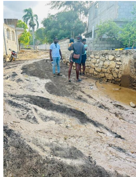
Constat de la zone après les intempéries du 17 avril 2026 venant aggraver une situation humanitaire déjà précaire depuis le passage de l'ouragan Melissa.
